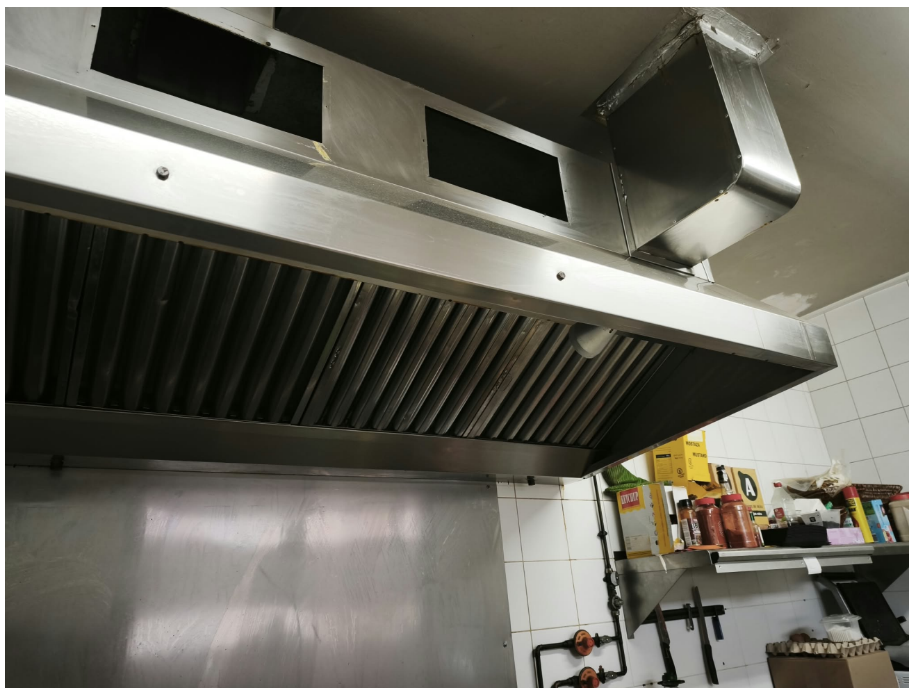
Fotografia 11. Campana extractora d'acer inoxidable.
